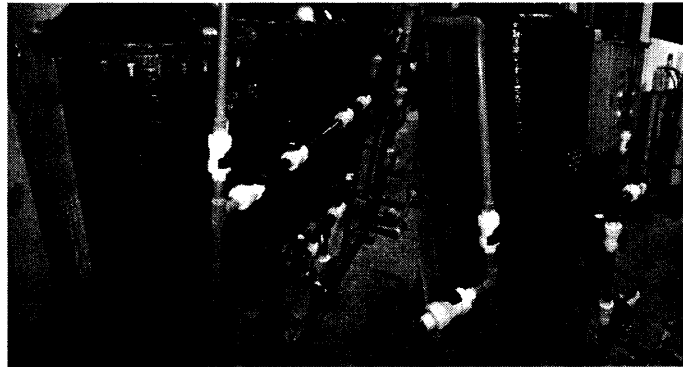
Foto No. 8. Tratamiento Terciario – Sistema de filtración (Arena/Carbón Activado)
